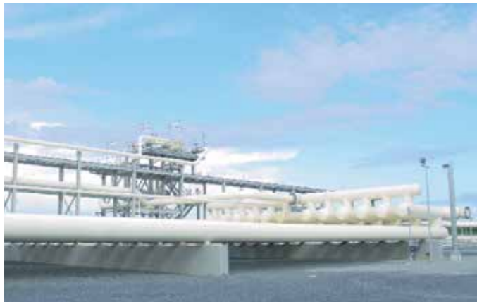
Рис. 3 Пробкоуловитель в системе многофазного транспорта
